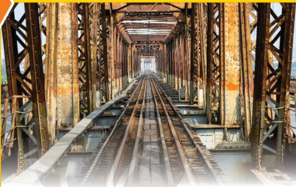
Kim loại bị gỉ do xảy ra các phản ứng oxi hoá – khử
